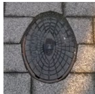
Einbau mit geschnittenen Platten
