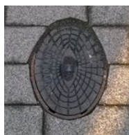
Einbau mit geschnittenen Platten
