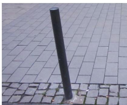
Einbau im Kleinpflasterstreifen
