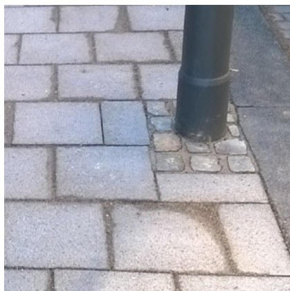
Einbau mit Kleinpflaster
