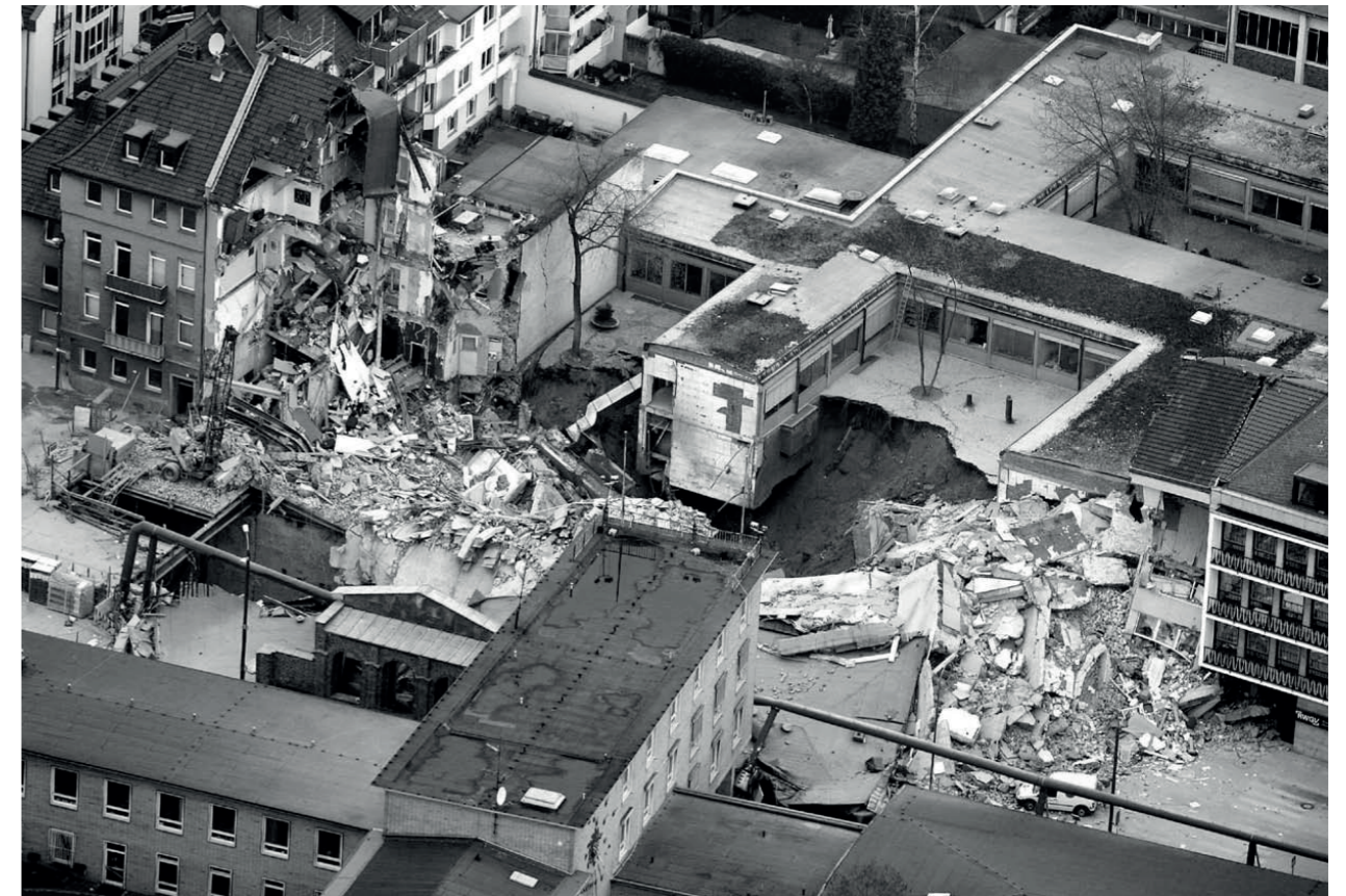
Luftbild unmittelbar nach dem Einsturz Foto: AKx-Reader
