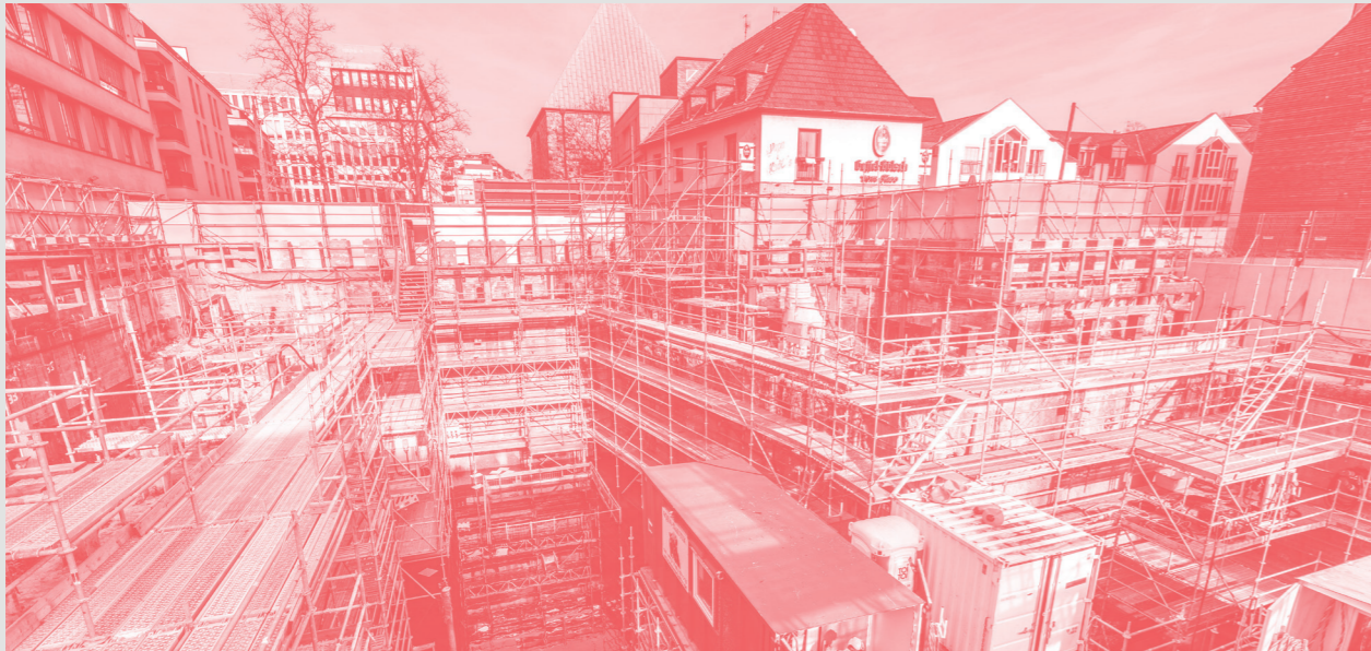
Baugrube und Baustelle am Waidmarkt Foto: Christoph Seelbach, KVB
