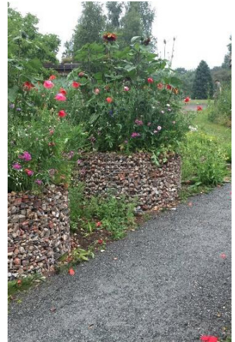
Bild: Gabionen mit Klinkerbruch, England, von Grassroofcompany John Little
