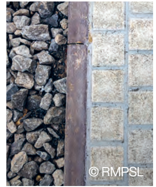
Gleiselement / Stahlkante / Kleinpflaster
