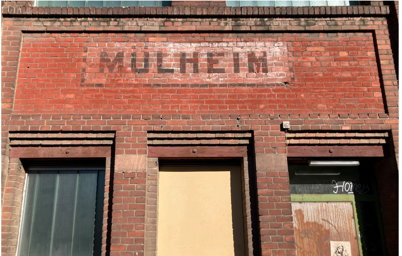
Abb. 7 Das Gebiet prägende historische Backsteinarchitektur (2023)
