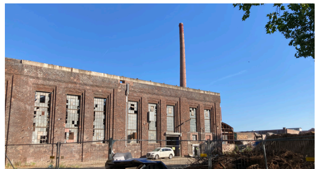
Abb. 14 Sanierung und Umbaumaßnahmen
