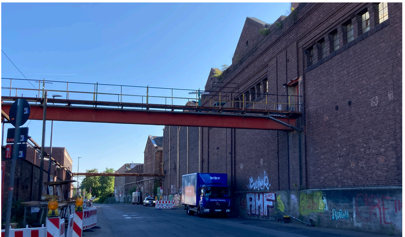
Abb. 8 Erschließung überwiegend über ehemalige Werksstraßen (2023)
