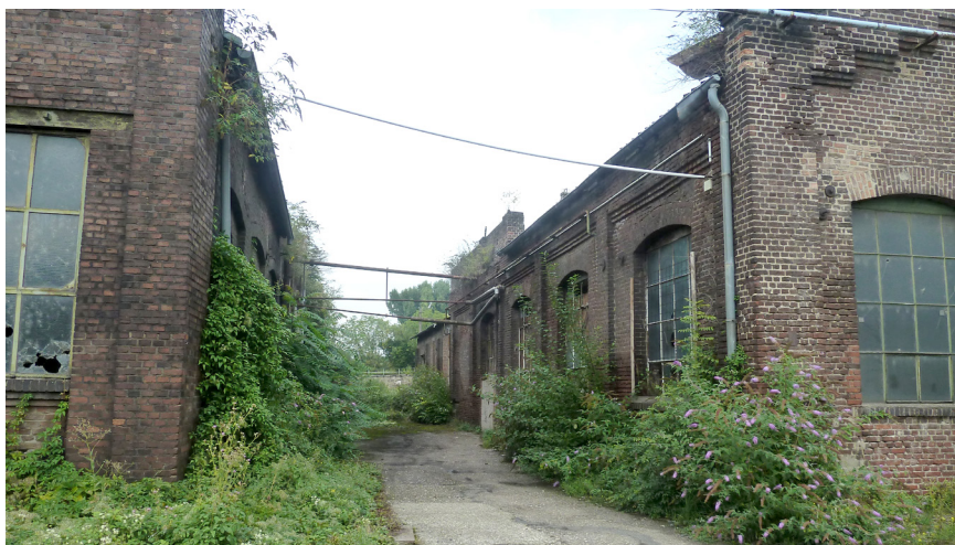
Abb. 19 Verwilderte Bausubstanz und Pionervegetation als Zeitzeugen einer vergangenen industriell geprägten Geschichte
