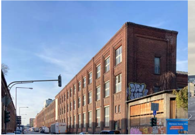
Straßenfront ehemalige Hauptverwaltung
