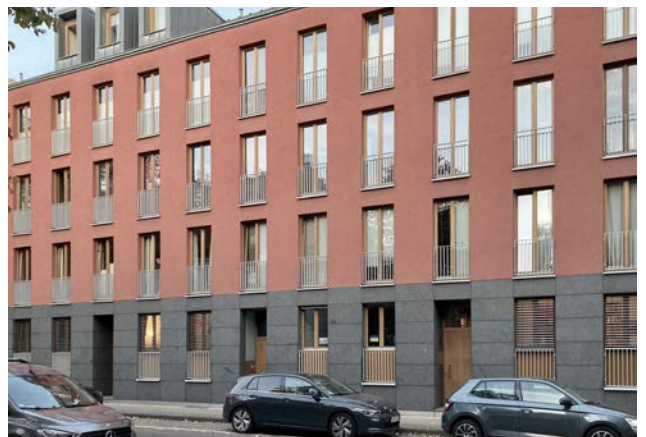
Putzfassade, Köln Nippes
