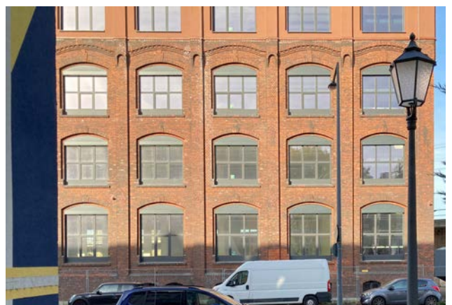
Bestandsfassade Euroforum West
