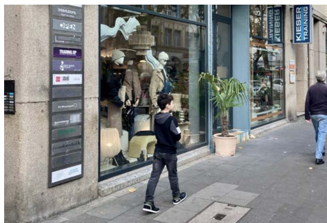
Natursteinfassade Gründerzeit, Agnesviertel
