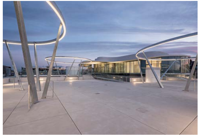
Dachterrasse der „Libelle“
