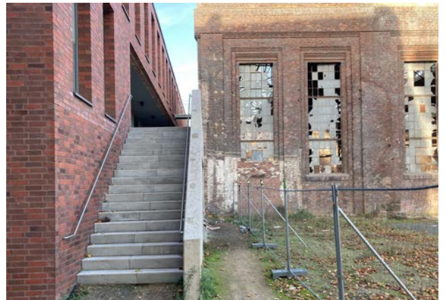
Neubau und Bestand Gelände Lindgens & Söhne
