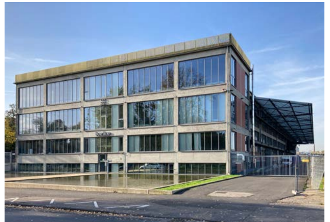
Nutzer Firma Beeline, Bestandsgebäude
