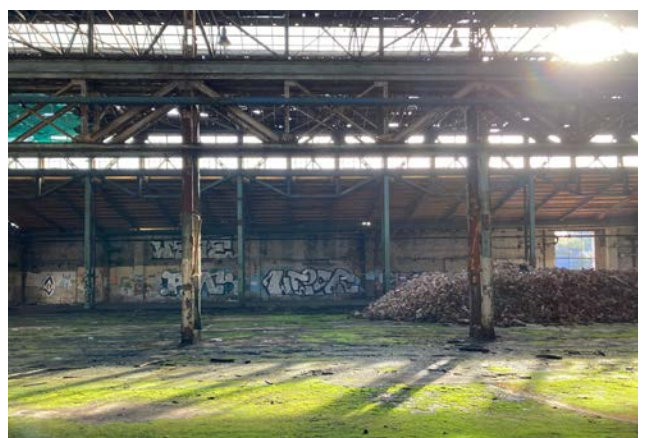
Werkhalle der Gasmotorenfabrik, Innenraum
