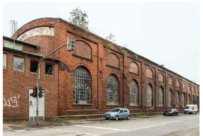
Denkmalgeschützte Hallen der Gasmotorenfabrik
