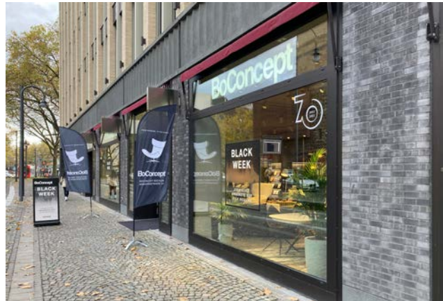
Sockel Klinker und Beton, Neubau, Innenstadt
