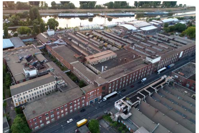
Dachlandschaft des Otto-Langen-Quartiers
