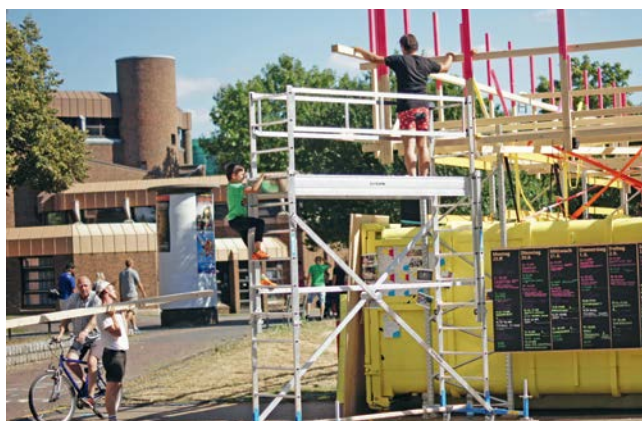
Die Platzstation bekommt ein Dach
