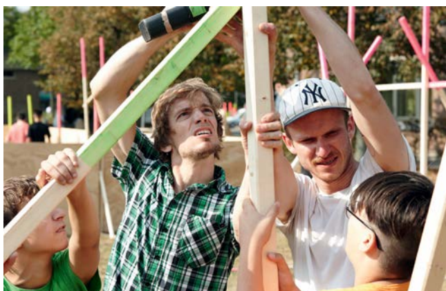
Bauaktion der Outdoor Gym
