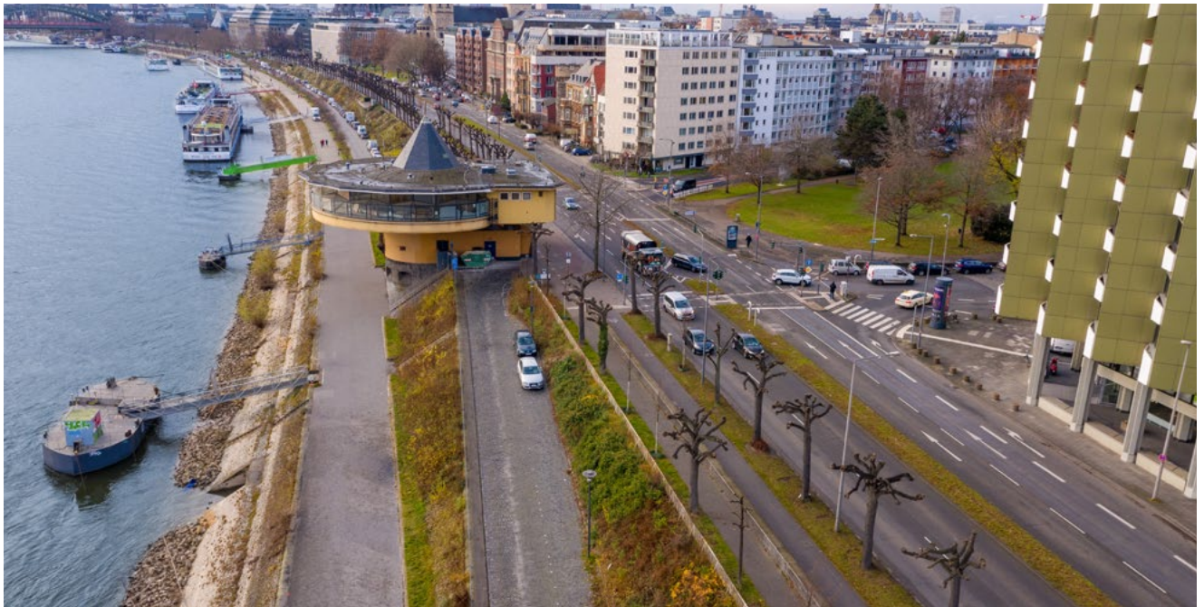
Abbildung 2: Nordansicht der Bastei
